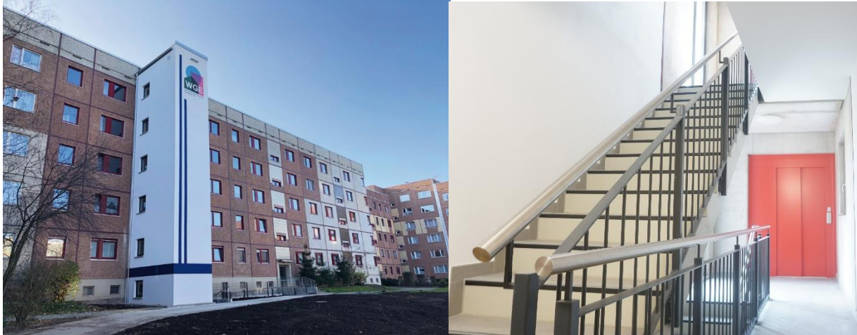
Impressionen: Anbau Aufzugsanlage Hirtenstraße 6
